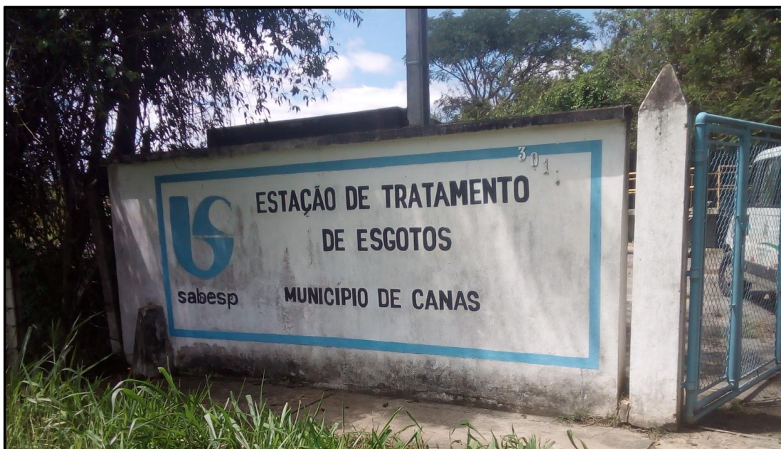
Figura 59. Entrada da ETE do município de Canas (SP)
