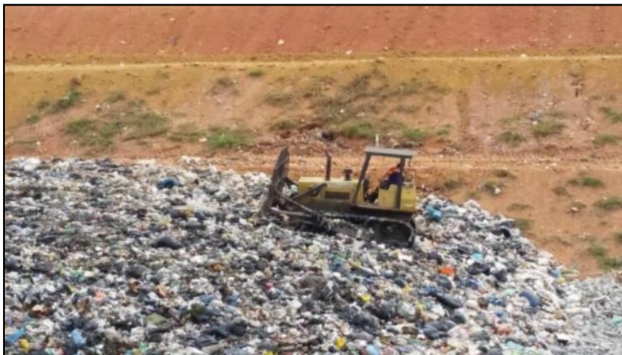
Figura 49. Área de operação do VSA durante compactação dos resíduos.
