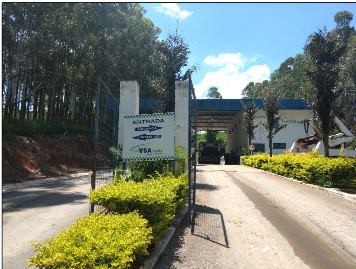
Figura 48. Entrada do aterro sanitário VSA
