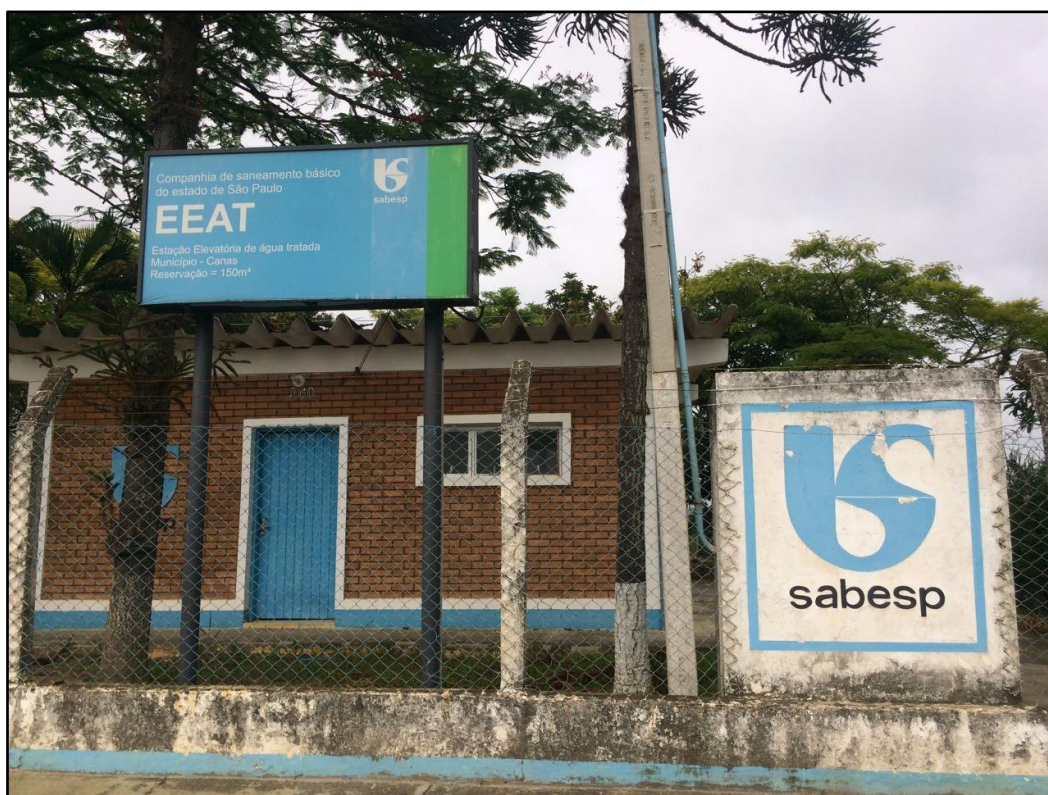
Figura 60. Entrada da ETA do município de Canas (SP).
