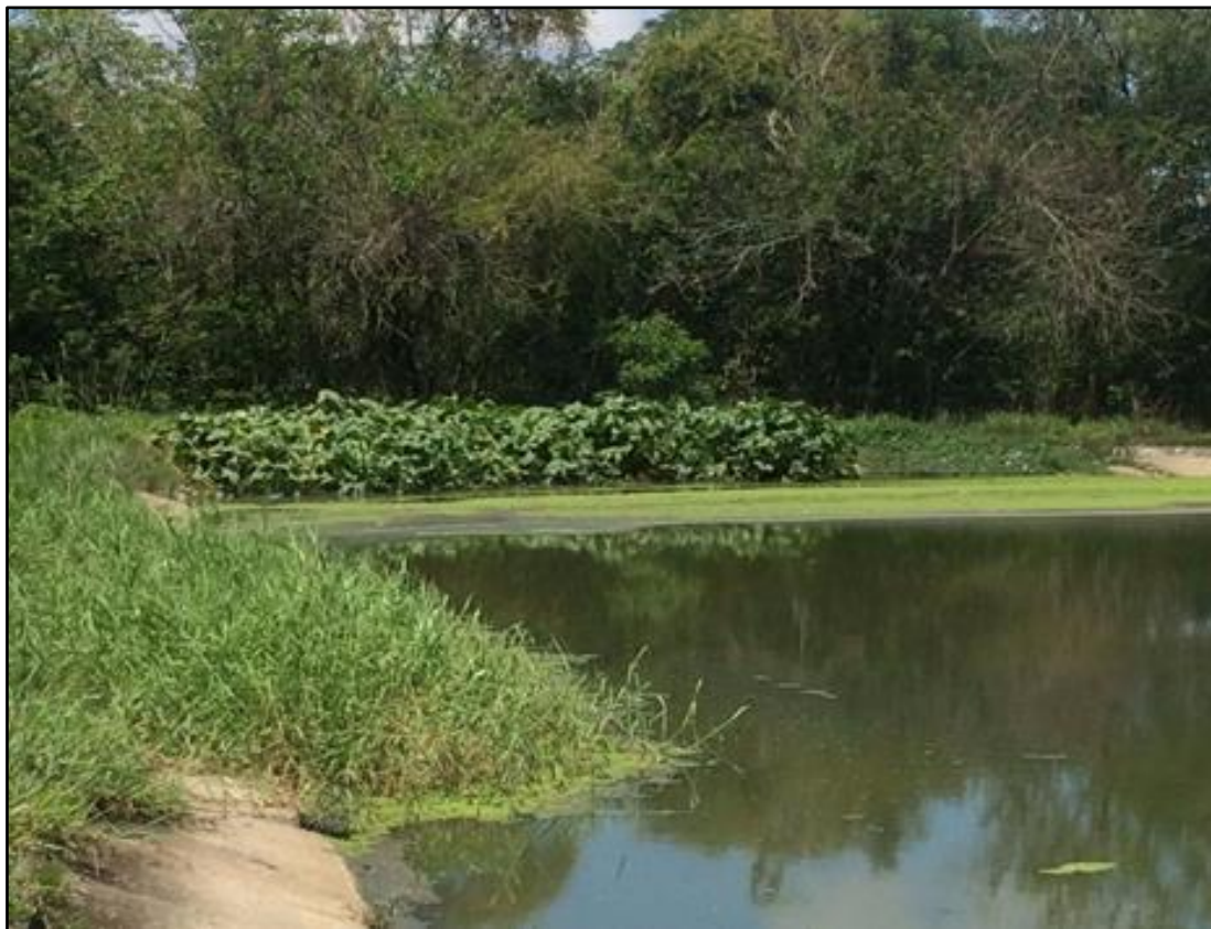
Figura 61. Crescimento de vegetação na lagoa facultativa da ETE de Canas (SP).
